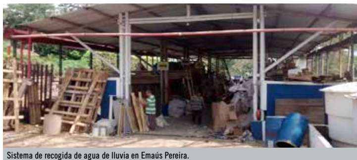
Sistema de recogida de agua de lluvia en Emaús Pereira.
